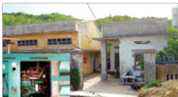
Trạm phát Diesel Nhơn Châu sắp hoàn thành sứ mệnh lịch sử
