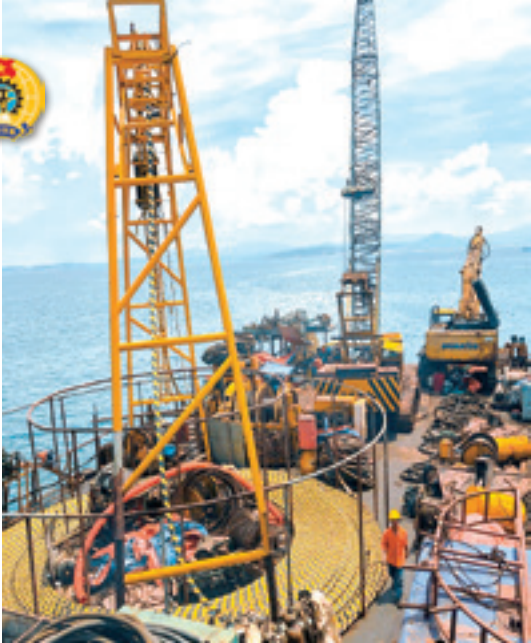
Thi công cáp ngầm vượt biển cáp điện cho đảo Cù Lao Xanh
