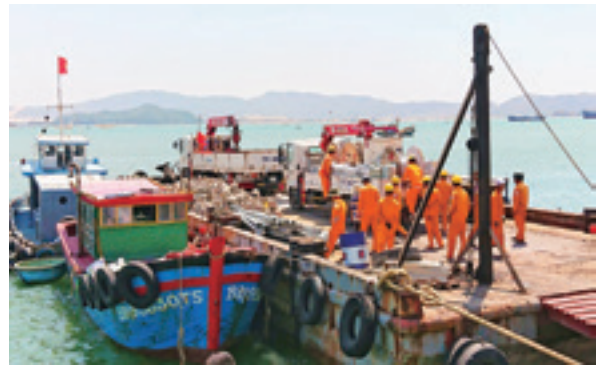
Công nhân Điện lực Quy Nhơn vận chuyển vật tư để cáp điện cho đảo Cù Lao Xanh
